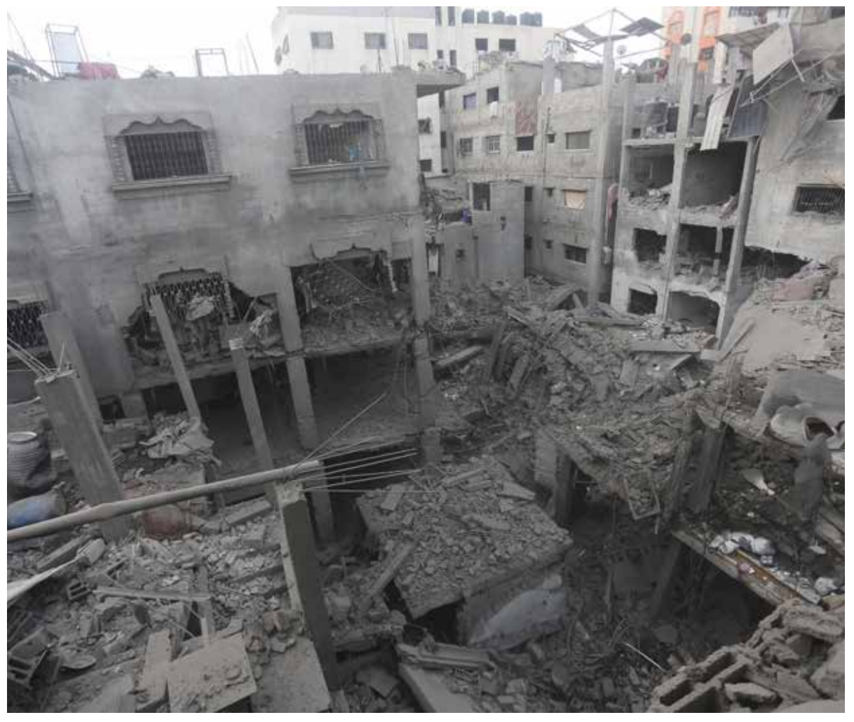
دمار واسع من جراء قصف الاحتلال لمربع سكني في الشاطي (تصوير/ محمود أبو حصيرة)
