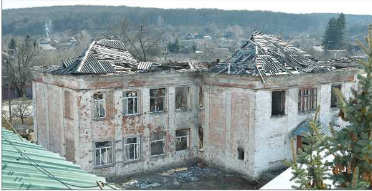
آثار القصف على مبنى في خاركييف (أ ف ب)
